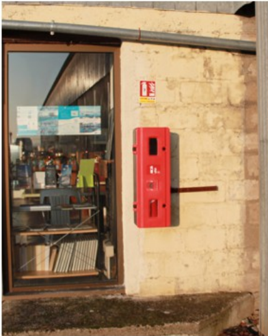
Mur Club House coté Hangar Nord
